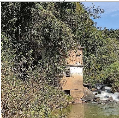
Foto 3: Vista parcial da antiga estrutura da usina hidrelétrica desativada, ao lado da cachoeira. Alex Alves Pereira, 18 jul. 2025.
