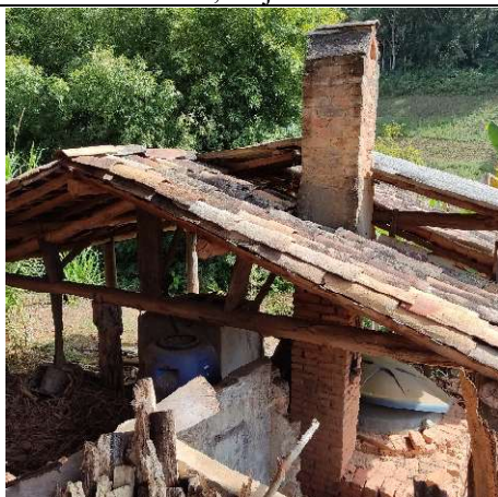
Foto 3: Vista do abrigo do forno do engenho com chaminé. Alex Alves Pereira, 18 jul. 2025.
