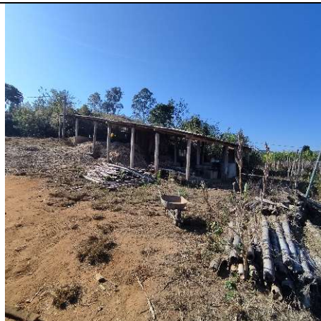
Foto 2: Vista do abrigo que comporta o engenho. Alex Alves Pereira, 18 jul. 2025.
