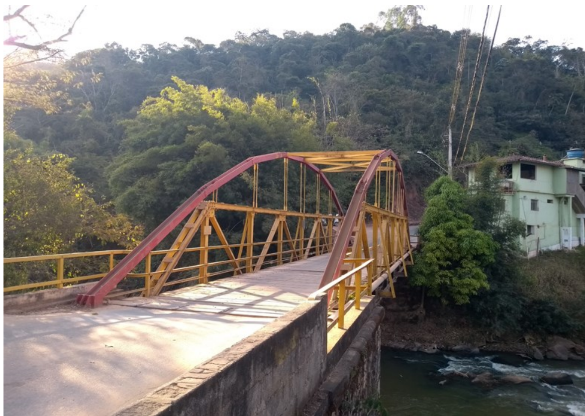
Ponte de Ferro sobre o Rio Xopotó
