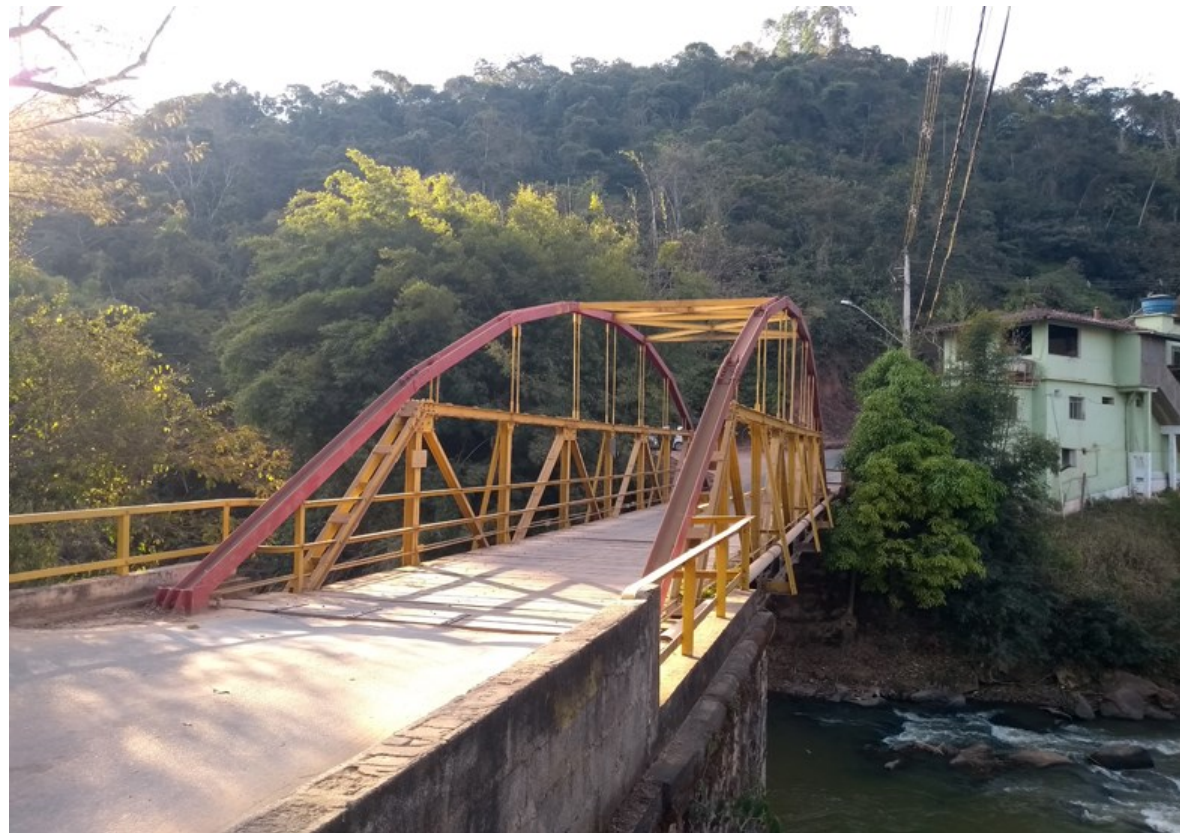
Ponte de Ferro sobre o Rio Xopotó
